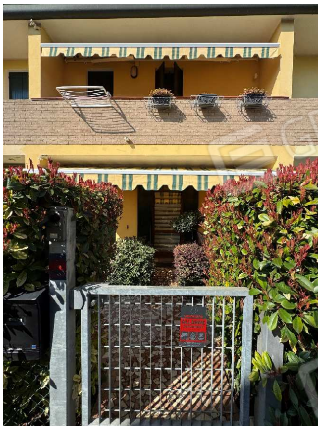
FOTO 3: Fronte prospetto Sud del bene oggetto di stima
