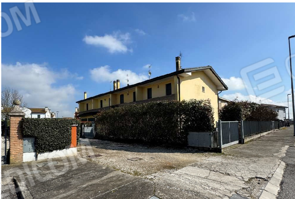
FOTO 2: Accesso carraio- fronte Nord del fabbricato
