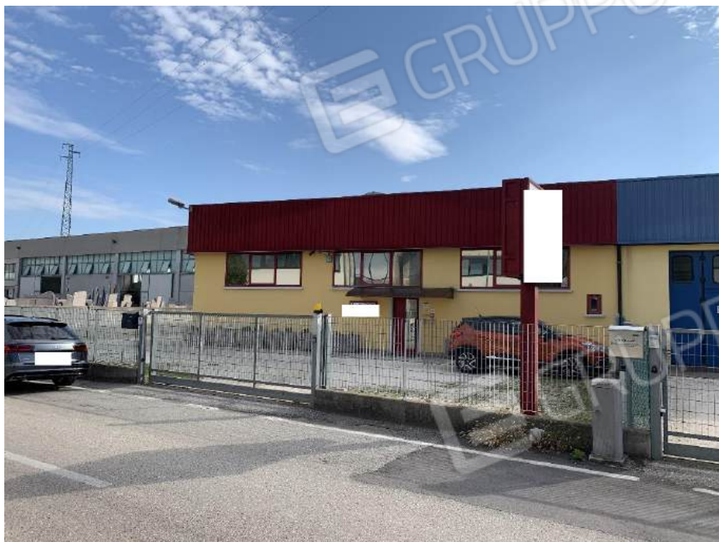
1) VISTA FRONTE FABBRICATO LATO EST
