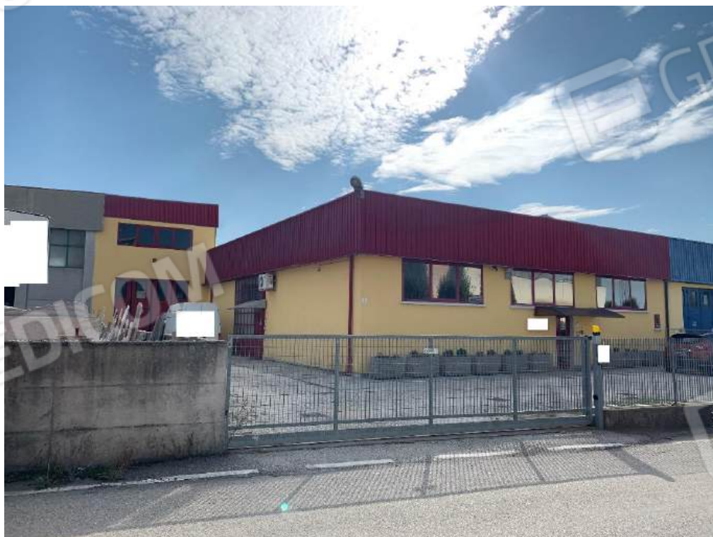
2) VISTA LATO NORD-EST DEL FABBRICATO
