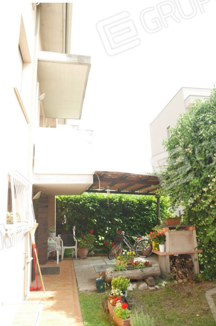
FOTO 4 - La struttura in legno in giardino.
