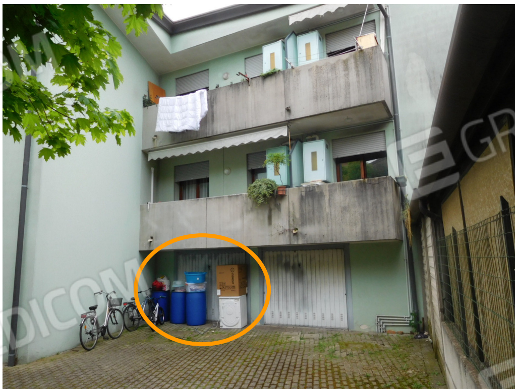
Box auto in area cortilizia condominiale subalterno 10
