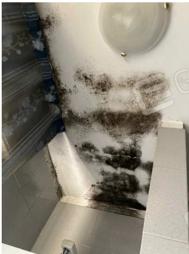
Foto n. 12: Particolare macchia umidità nel soffitto della zona doccia
