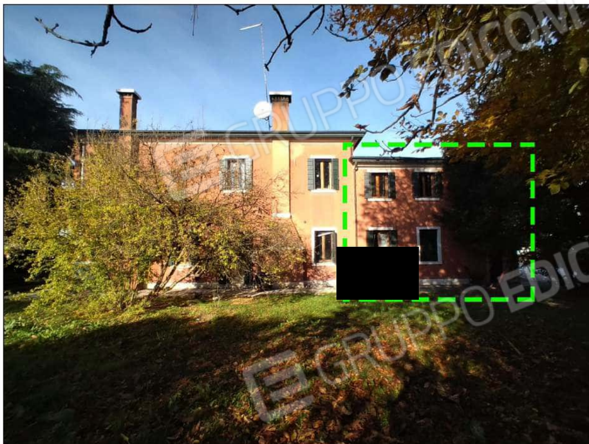
foto 08 - area esterna e fronte est
