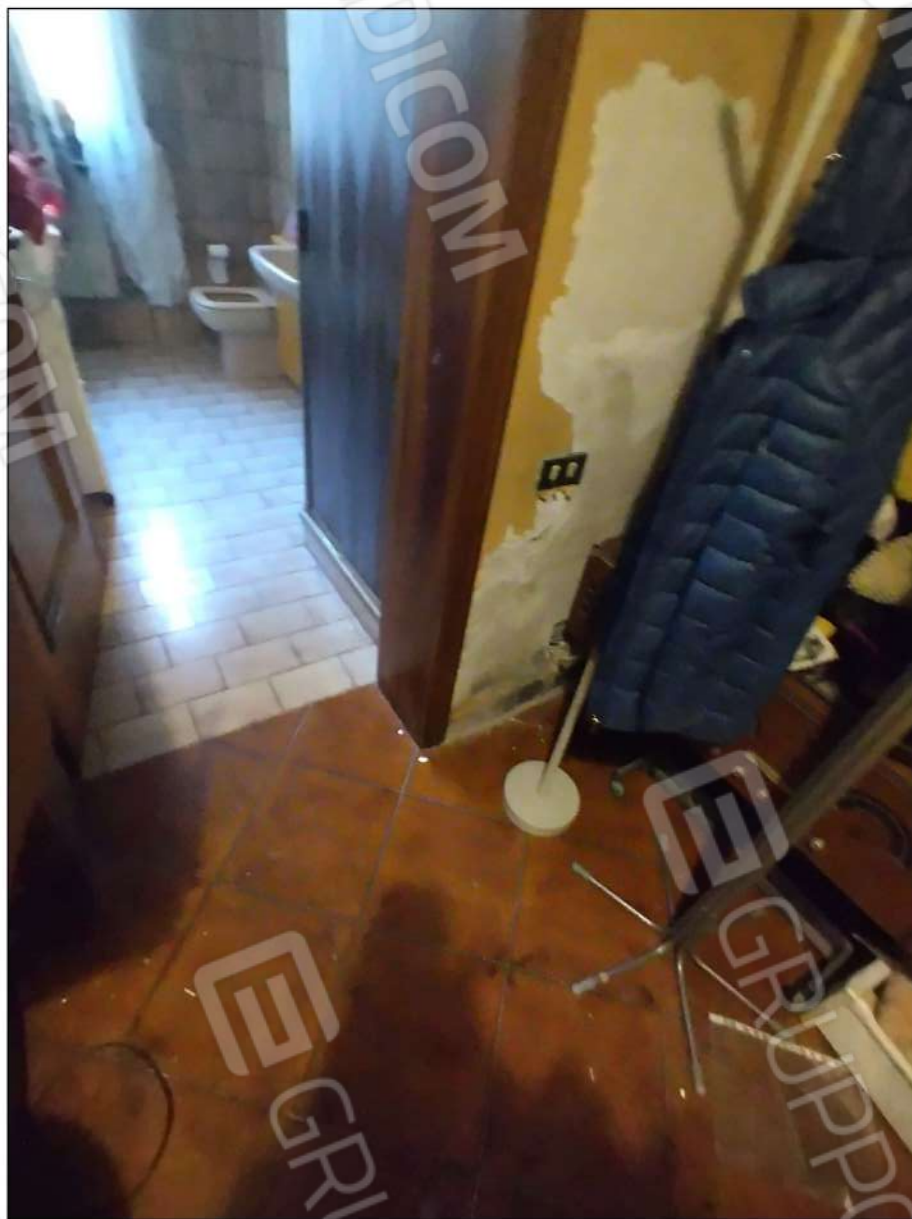
foto 24 -dettaglio disimpegno comune
