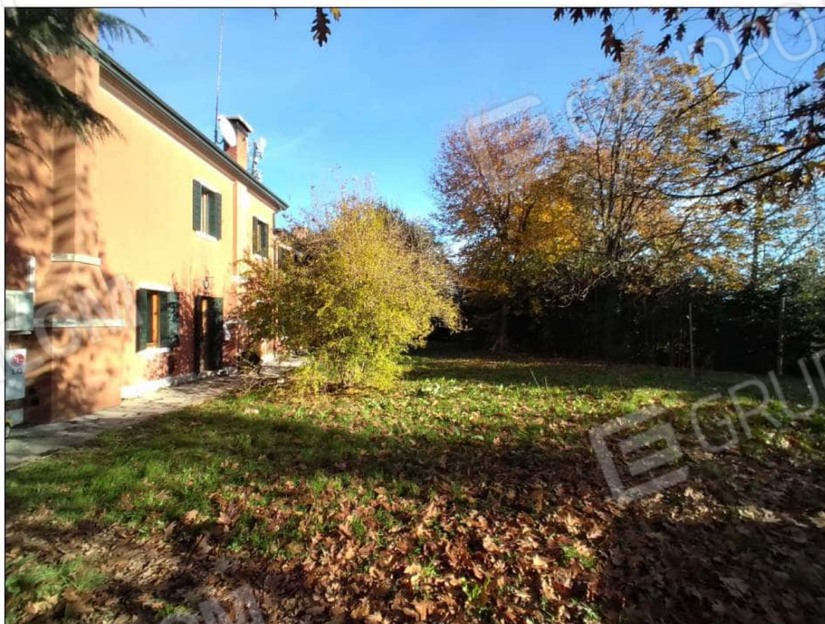
foto 09 - area esterna lato est
