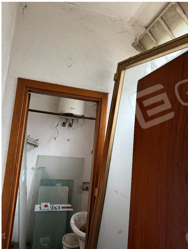
Veduta locale w.c.
