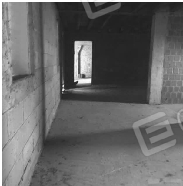
Foto 21: Fabbricato rurale lotto –D- veduta interna.
