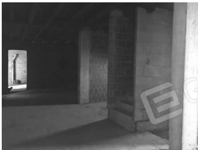
Foto 15 : Fabbricato rurale lotto -D- veduta interna.
