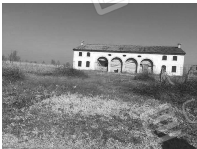
Foto 12: Vista d'insieme del fabbricato rurale lotto –D–.
