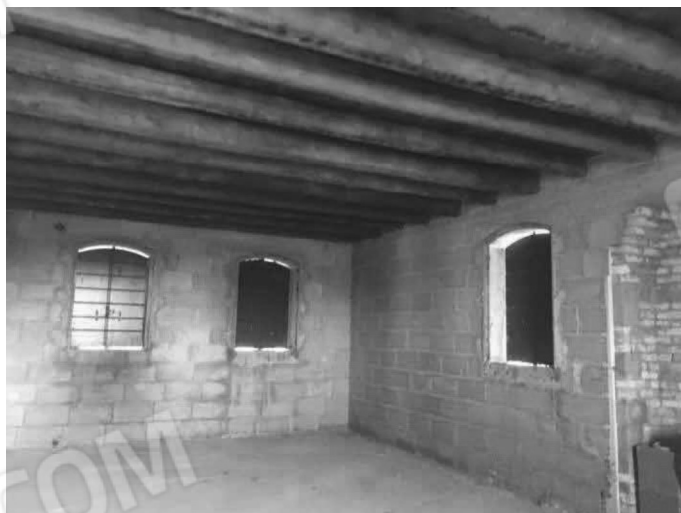
Foto 16: Fabbricato rurale lotto -D- veduta interna.
