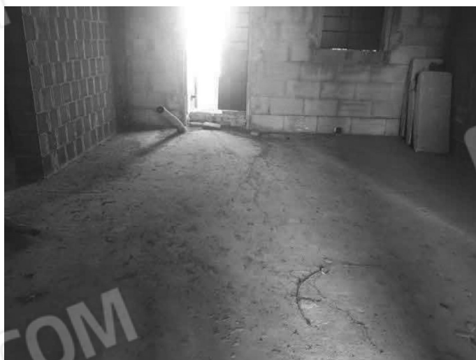
Foto 19: Fabbricato rurale lotto -D- veduta interna.
