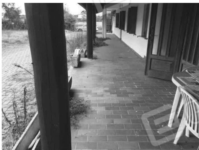
Foto 6: Fabbricato lotto -A- portico.
