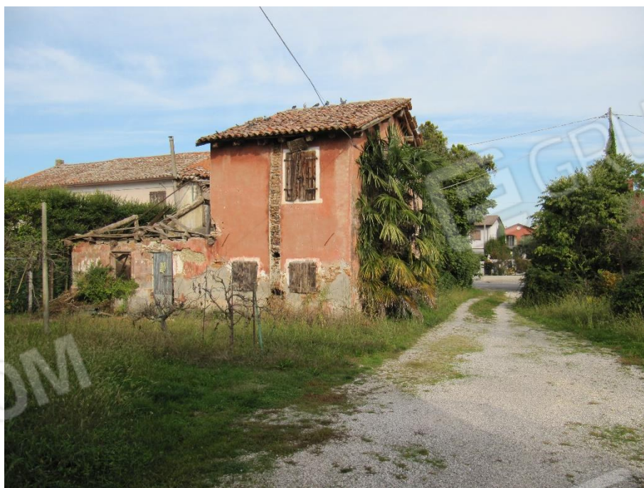
L'edificio che insiste sul mappale 1155. Vista da Sud verso Nord con percorso passaggio carraio e pedonale verso la via Bigolo.
