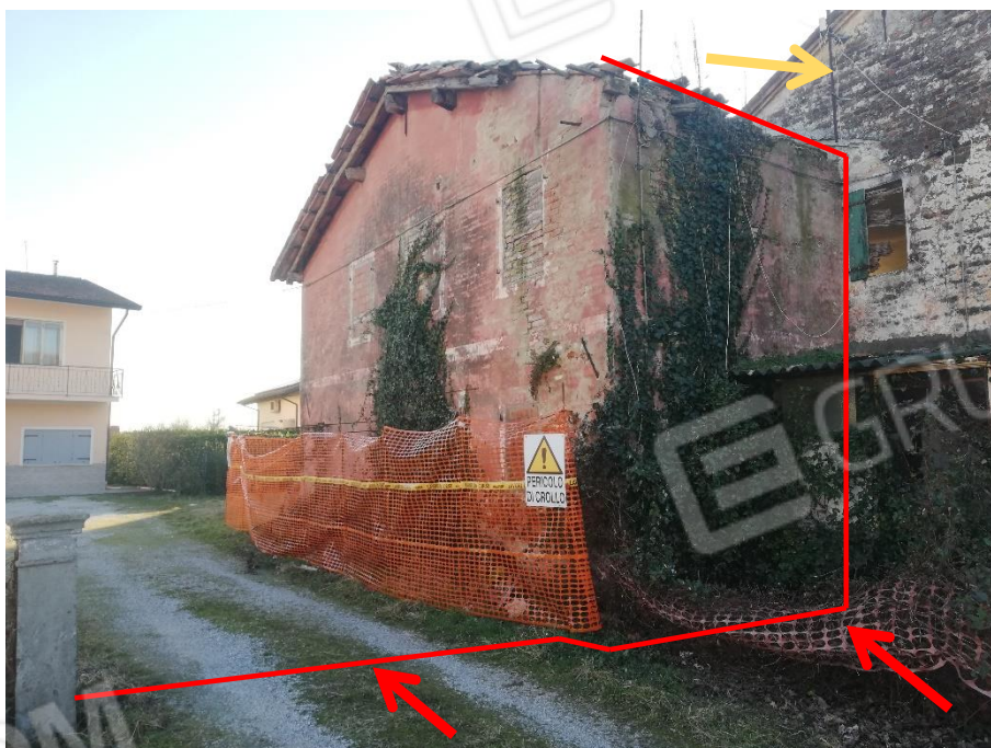
Vista da nord verso sud: identificazione dello scoperto ed edificio del mapp 1155 (freccie rosse). Con freccia gialla edificio mapp. 1013
