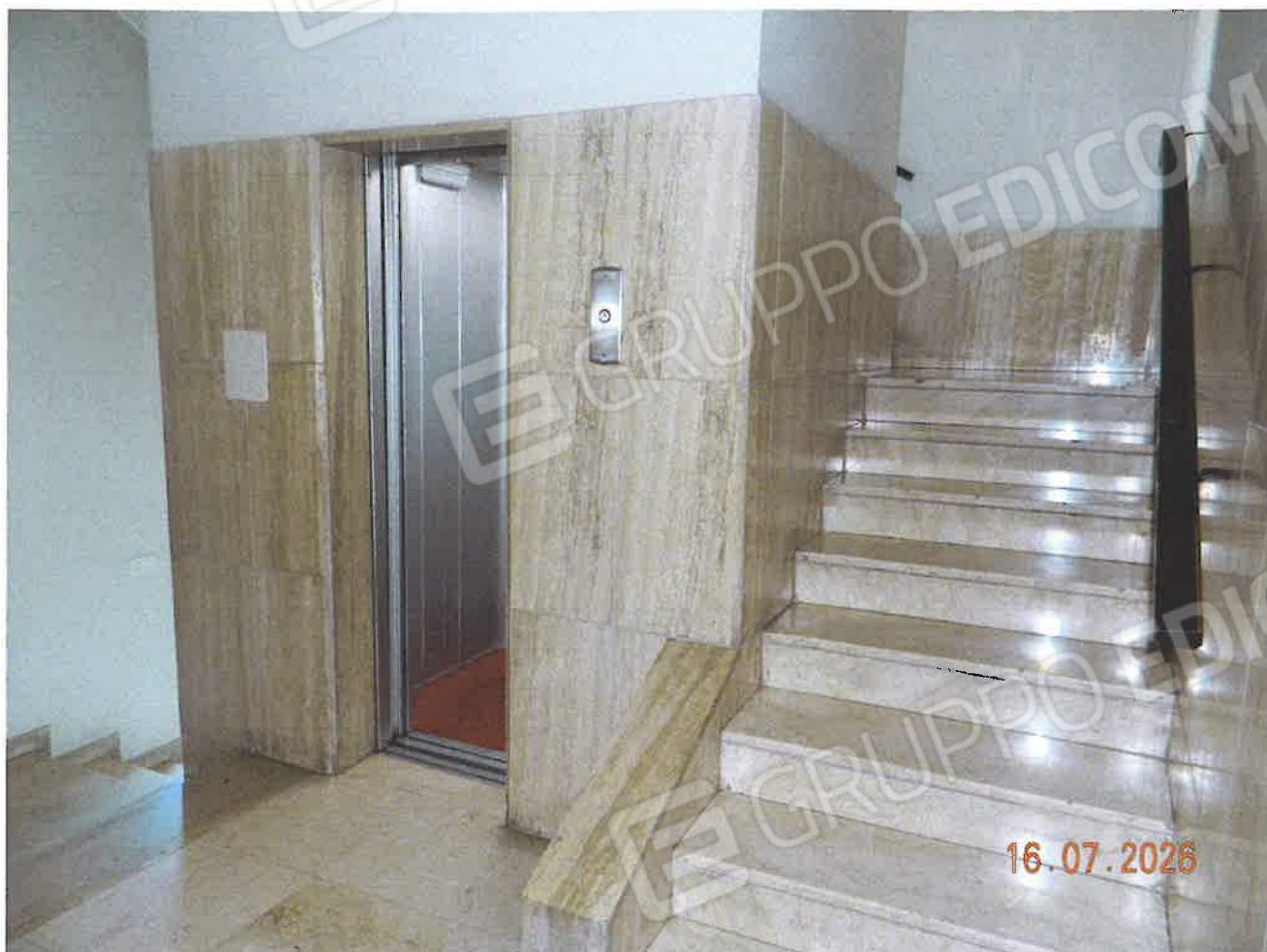
Vista del vano scala e del vano ascensore (civico n. 8)
