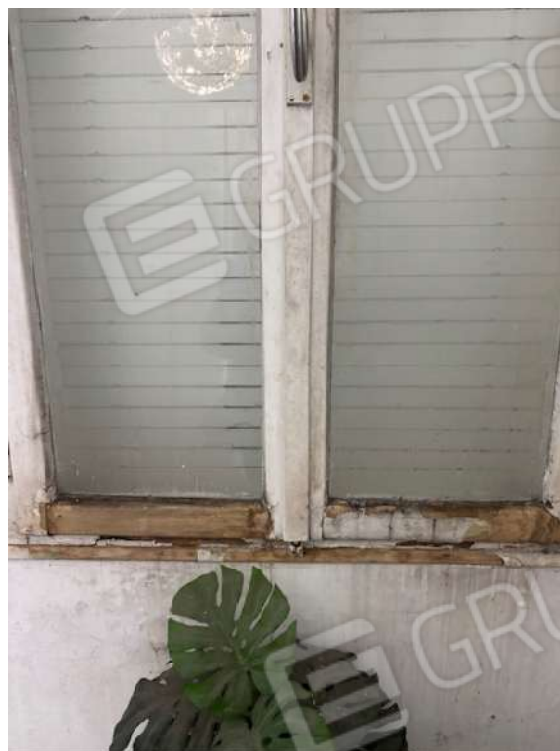
Vista serramento interno
