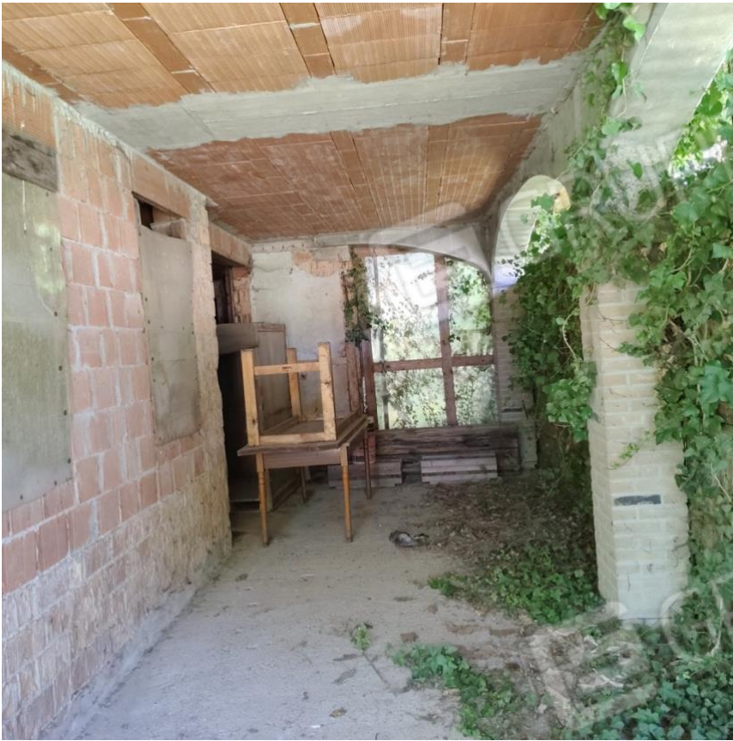
10 - lotto 1 Corpo A portico
