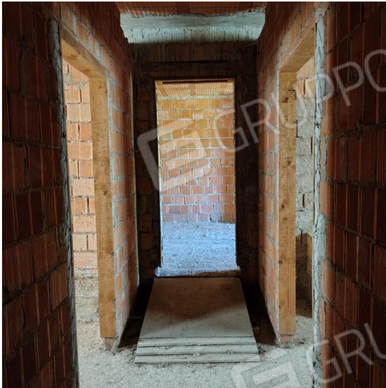
26 - lotto 1 Corpo C ripostiglio agricolo p.1
