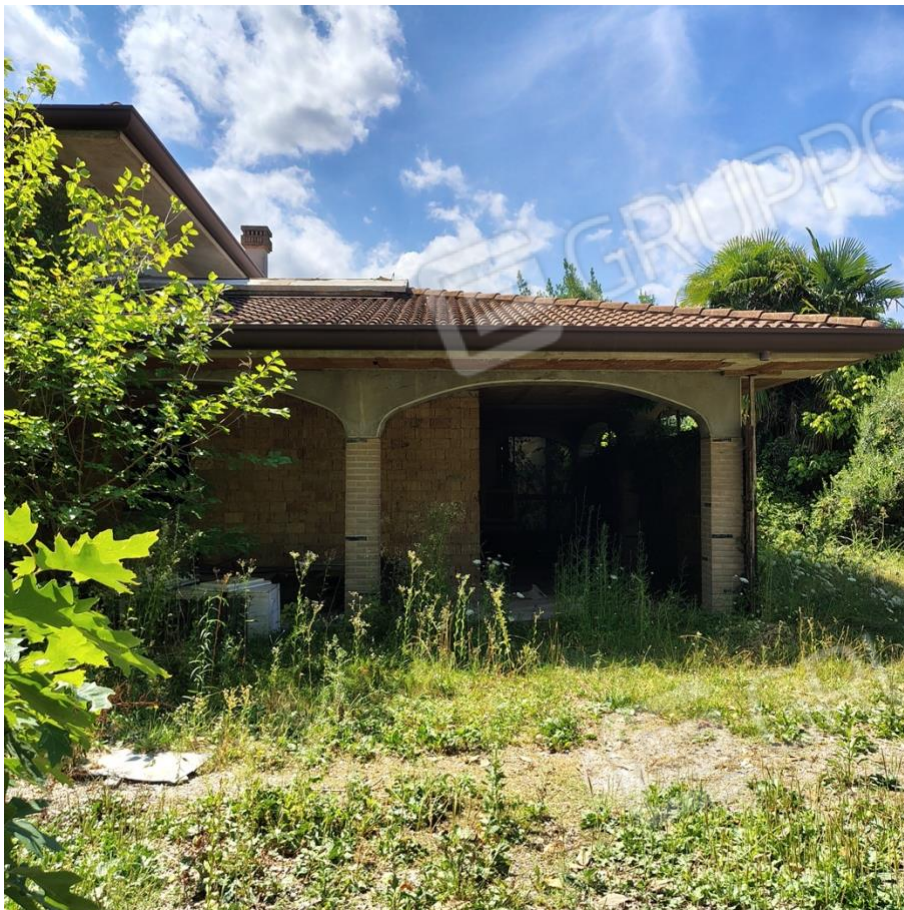
3 - lotto 1 Corpo A portico
