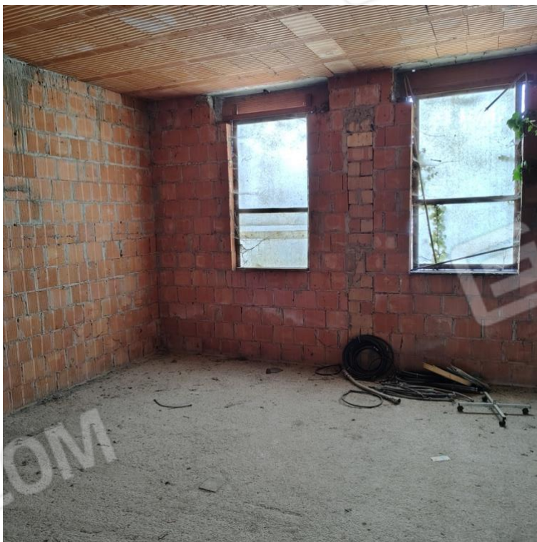
27 - lotto 1 Corpo C ripostiglio p.1
