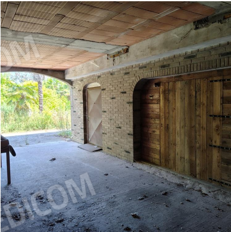
17 - lotto 1 Corpo B autorimessa
