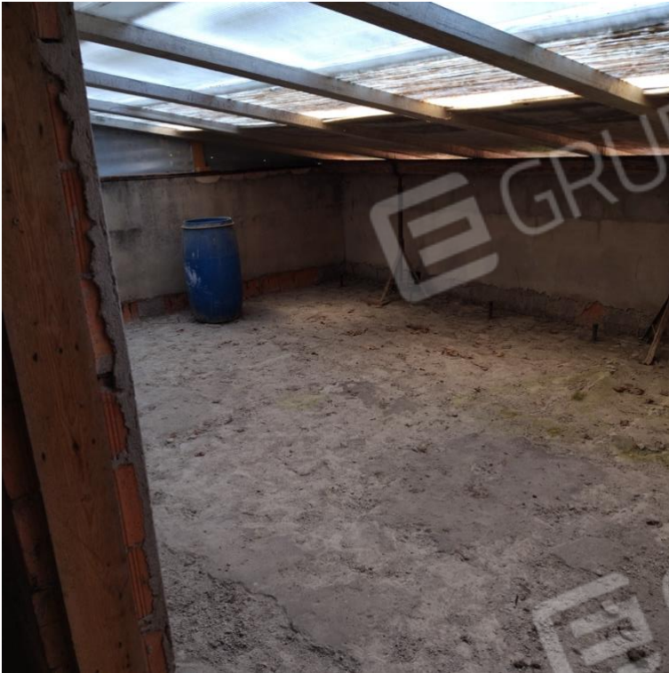
14 lotto 1 - Corpo A terrazza con copertura provvisoria
