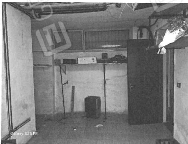
Foto n. 14 – vista piano interrato
