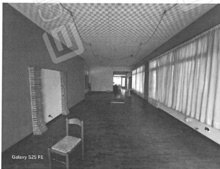
Foto n. 6 – vista sala interna
