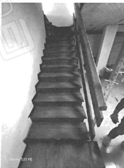
Foto n. 12 – vista scala interna
