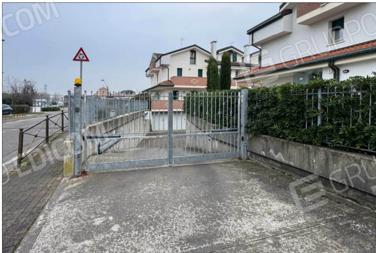
Foto n. 07) Particolare dell'accesso carraio su via P.E. Venturini
