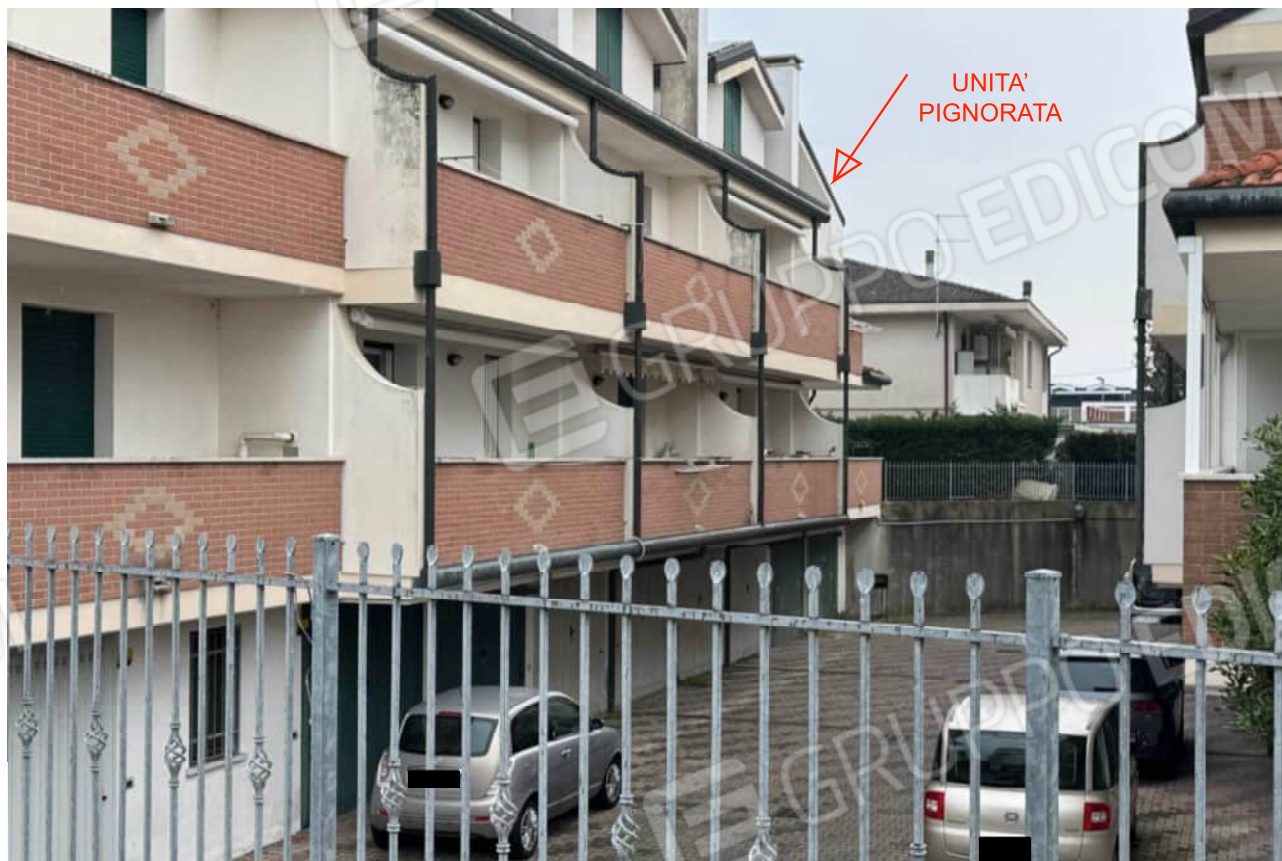
Foto n. 08) Vista dell'area di accesso ai garage
