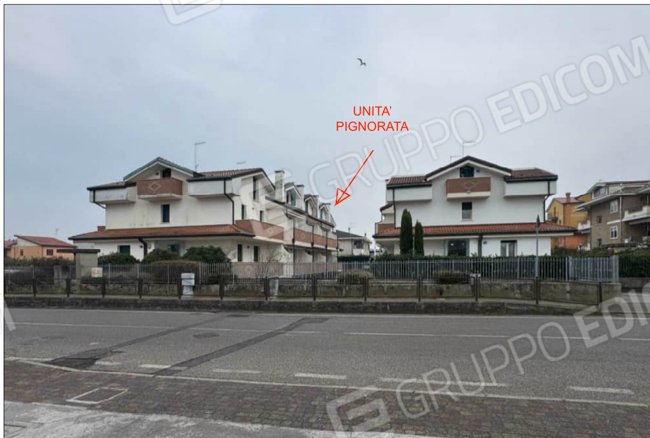
Foto n. 06) Vista del complesso fronte via P.E. Venturini
