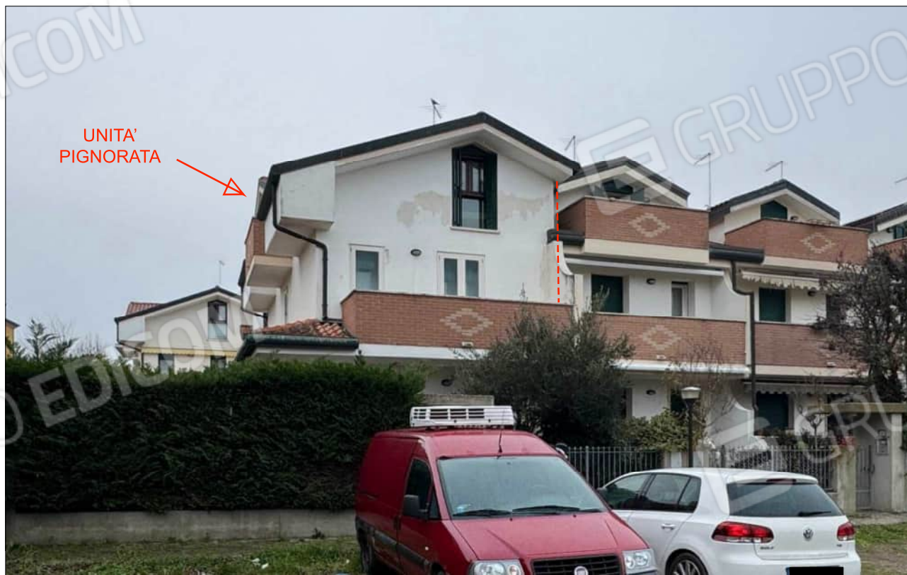
Foto n. 02) Vista dei prospetti est e sud
