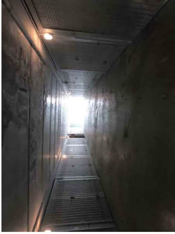
Corsia di manovra (sub.175)
