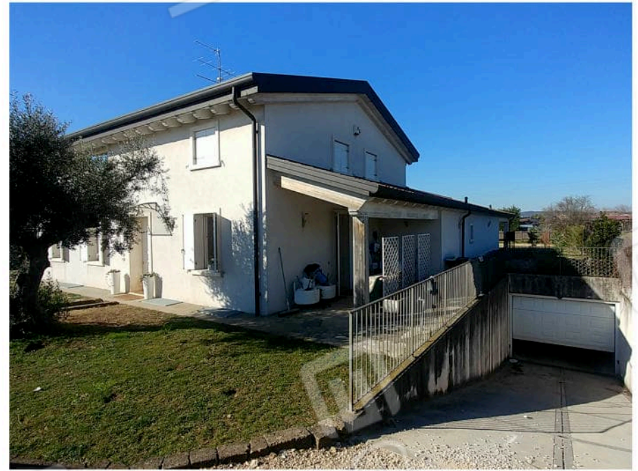
02 vista esterna del fabbricato lato nord-est
