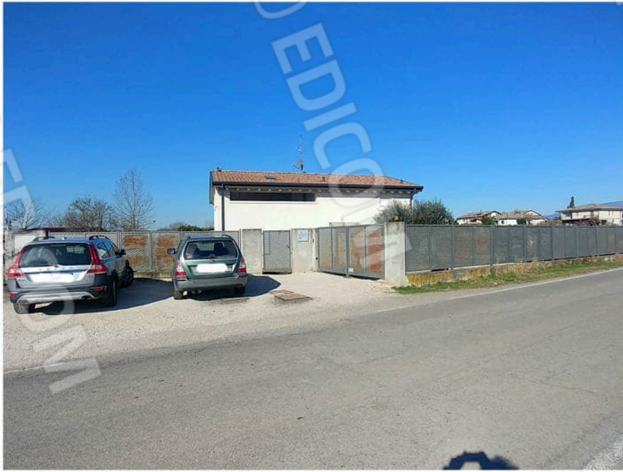
01 vista esterna del fabbricato dalla strada
