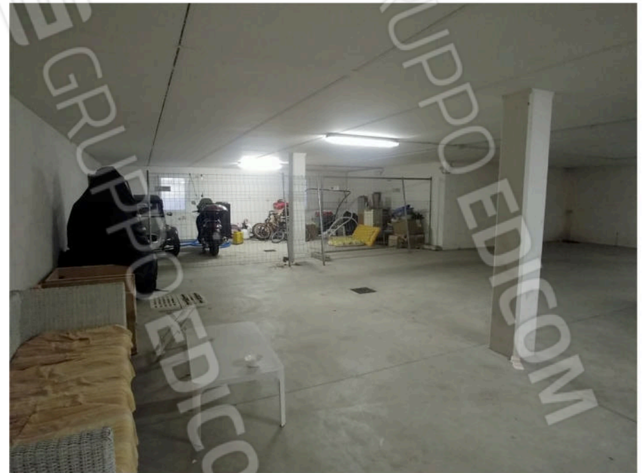
20 vista interna dell'autorimessa PS
