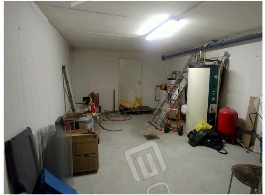
18 vista interna del deposito PS
