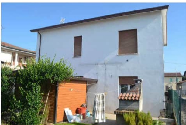
foto 1 - vista dal giardino sud del compendio bifamiliare sul m.n. 20, dove si osserva l'annesso accessorio denunciato in Comune ma non al catasto (in basso a sinistra nella foto) e con i segni di deterioramento sulla parete che, assieme al permanere delle sporgenze originarie dei davanzali, fanno pensare che l'applicazione del cappotto sia stata dichiarata ma mai davvero eseguita
