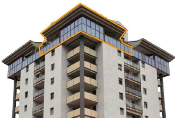
foto 2 - scorcio dei piani 11°/13° nell'angolo sud est del condominio GALILEO prospettante a sud (sinistra foto) sulla piazza Zinelli al n. 1 visto da sud est, con la vetrata del soggiorno e le terrazze panoramiche del m.n. 1970 sub 69 al piano 11° evidenziate in colore giallo
