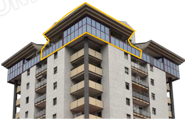
foto 5 - Scorcio da sud est del piano 11° dell'unità
