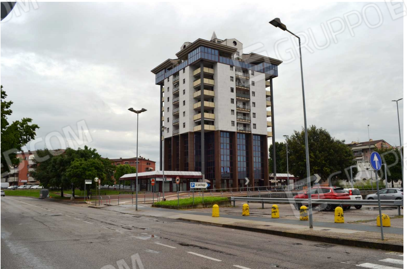
foto 3 - Prospetti ovest e sud del condominio GALILEO in piazza Zinelli n. 1 a San Giovanni Lupatoto
