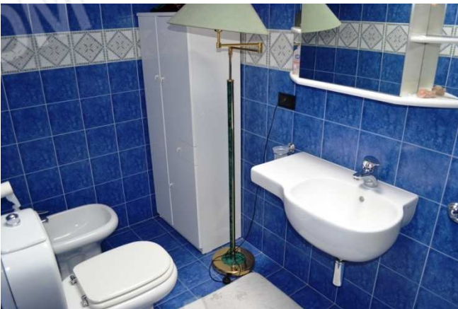
foto 25 - Vista interna del bagno del piano sottotetto
