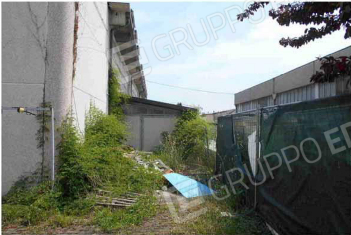
Vista deposito abusivo Sud
