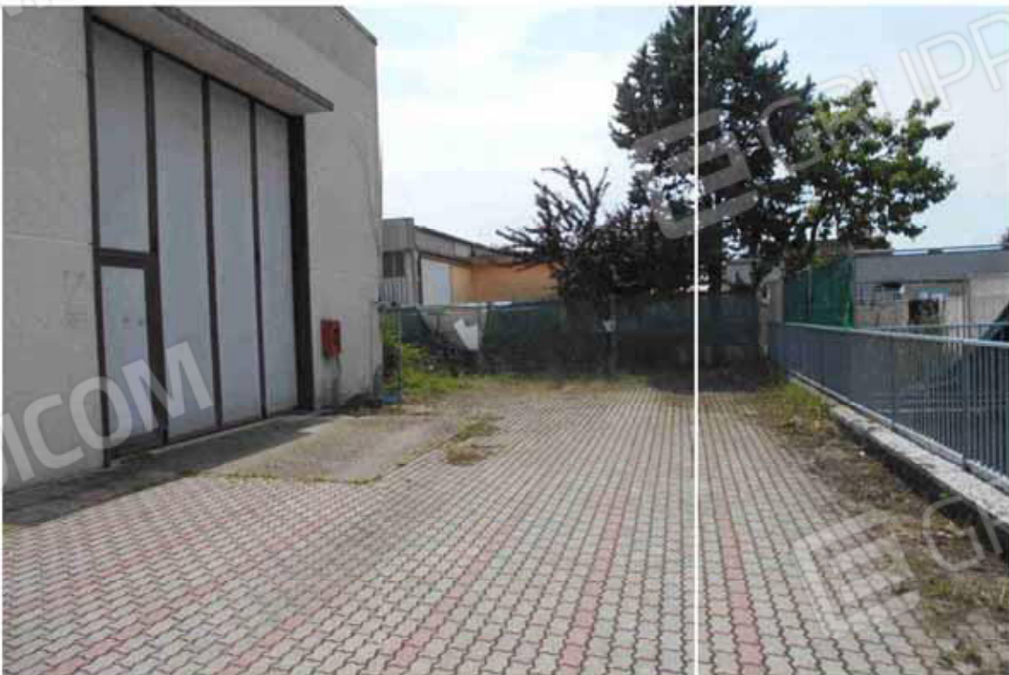
vista fronte Ovest
