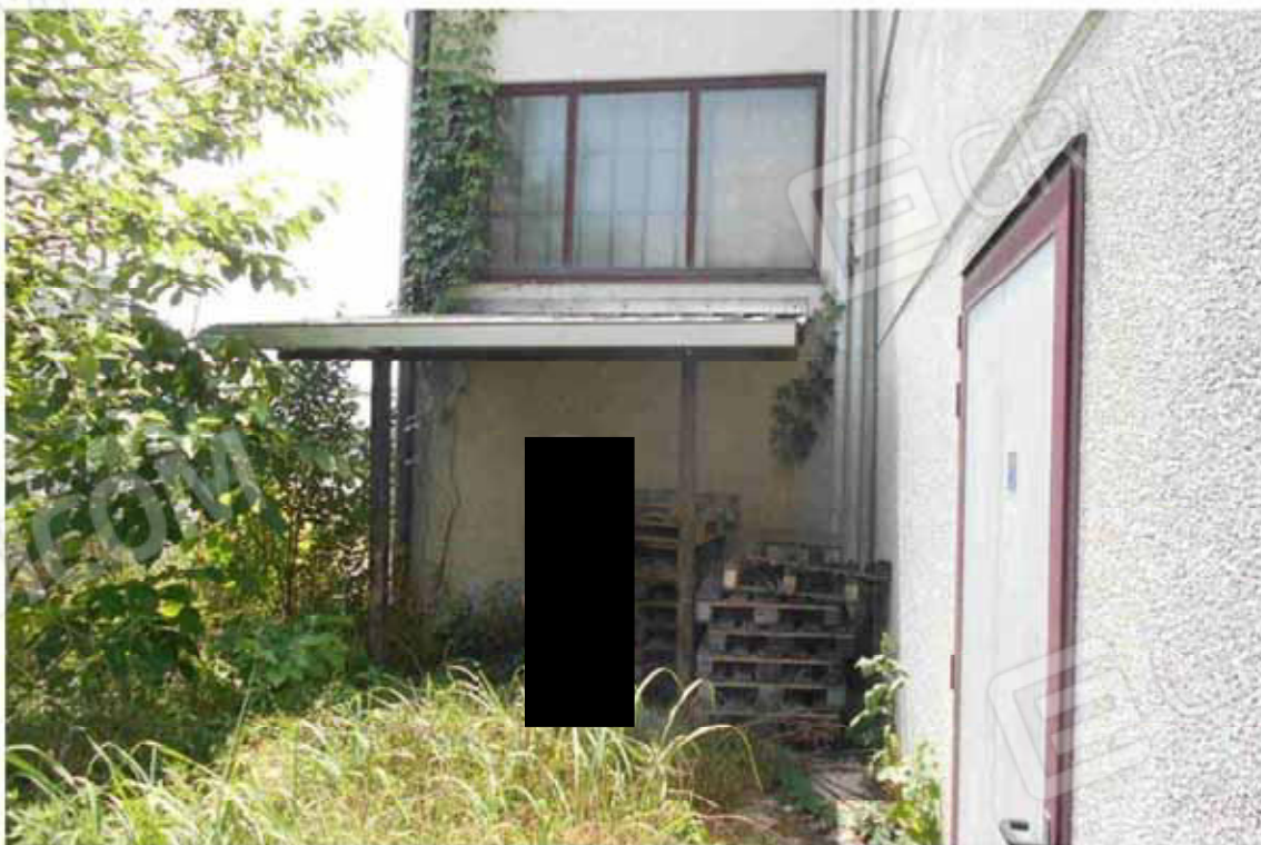
Vista tettoia lato Est
