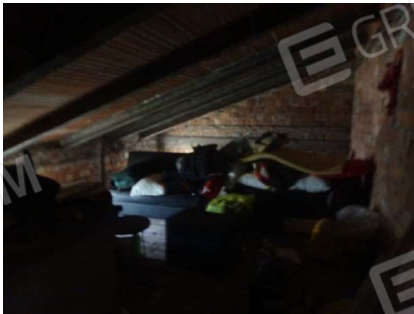
36 sottotetto — vani che affacciano su via TRIESTE p. secondo
