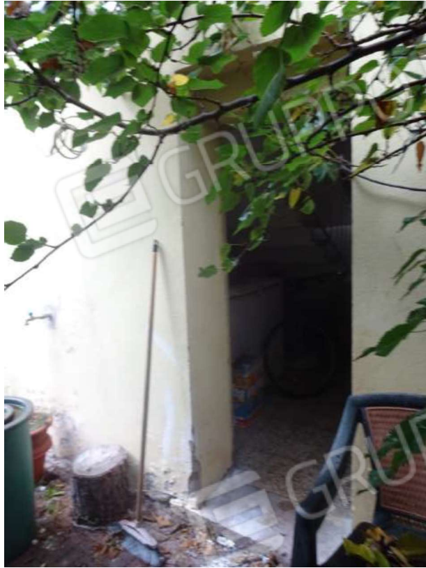
8 Porta d'uscita dal sub 7
