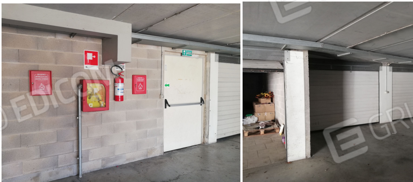
PORTA REI ANTIPANICO DETTAGLI INTERRATO
