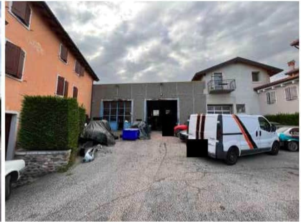
Prospetto est dell'edificio
