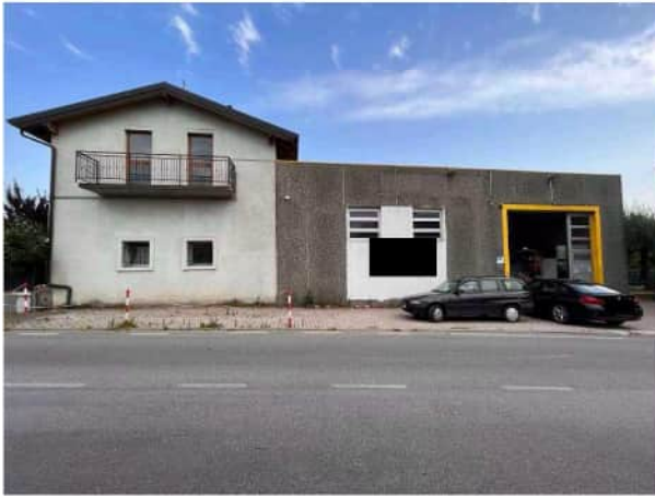
Fronte principale dell'edificio
