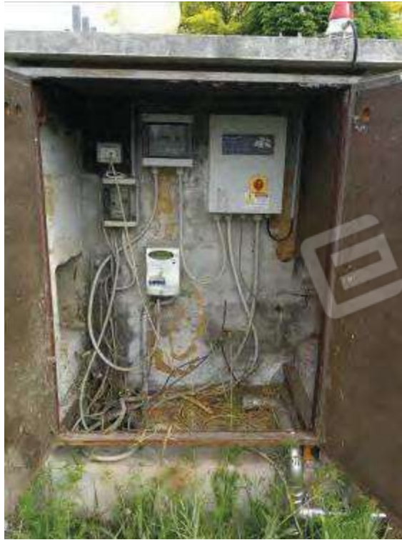
Quadro elettrico delle pompe di rilancio
