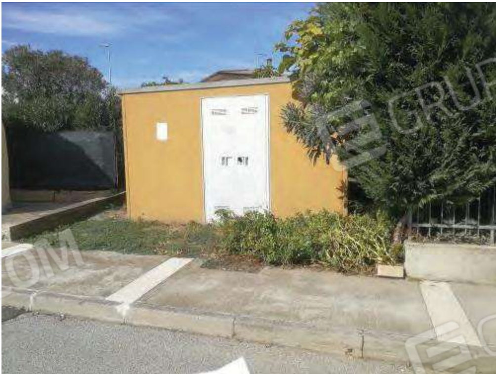
Foto del terreno con cabina fronte via Fossette
