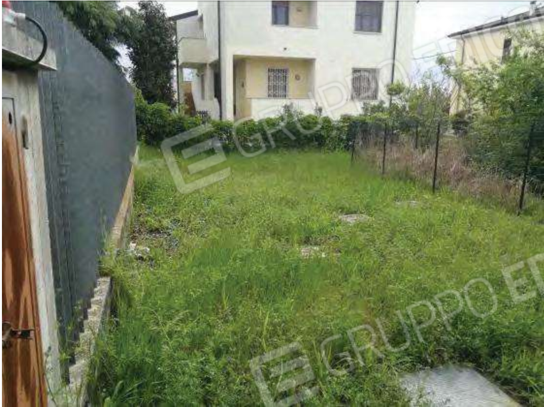
Presenza di numerosi pozzetti di ispezione per i pozzi perdenti sottostanti
