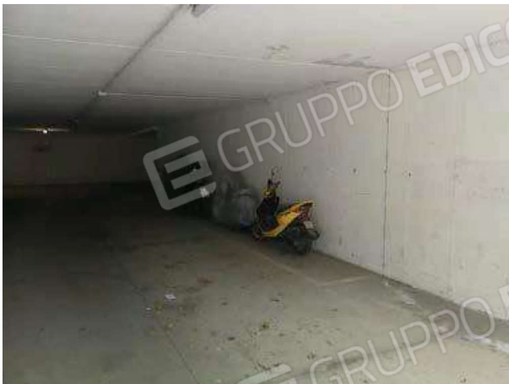
POSTO MOTO IN BATTUTO DI CEMENTO
