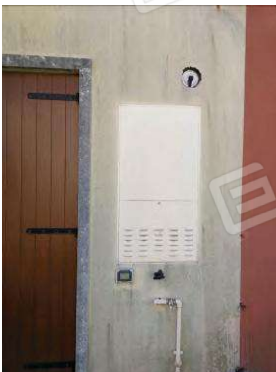
PREDISPOSIZIONE CALDAIA
