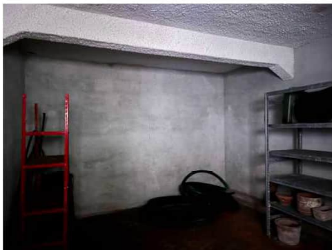
Deposito piano interrato
