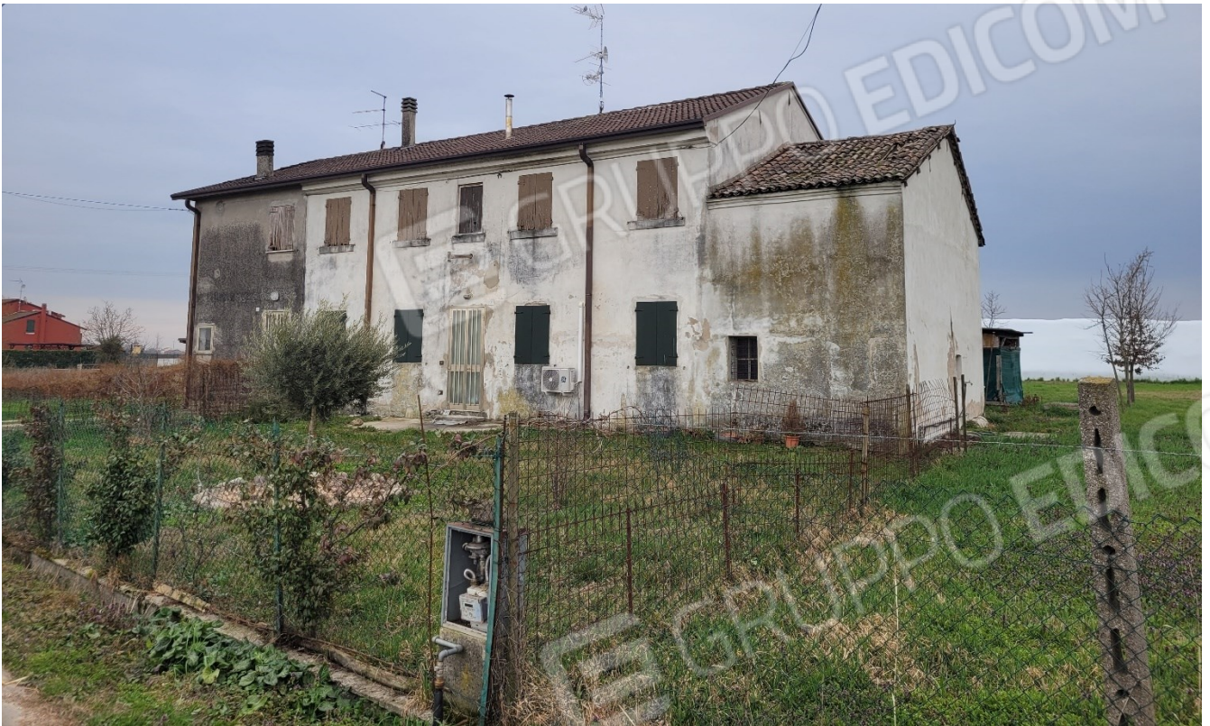
Vista del fronte del fabbricato da via Alberetto (lato nord)
