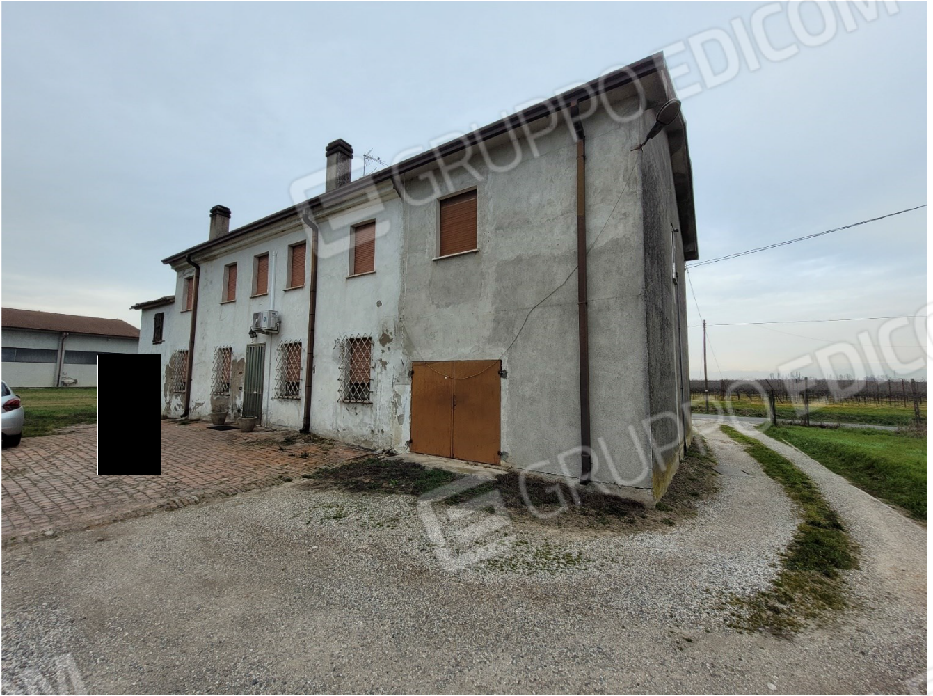
Mappale 444 in primo piano e porzione del Mappale 443 (a lato del fabbricato) che danno accesso alla corte
