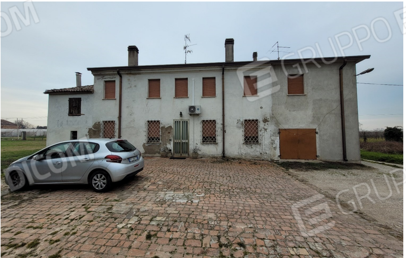
Vista del retro del fabbricato (lato sud)
