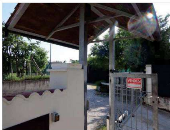
La rampa del garage che inizia la pendenza in prossimità del cancello carrabile
