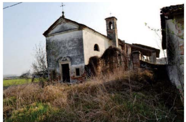
foto 5 - Prospetto ovest dell'ex Chiesetta visto da sud ovest
