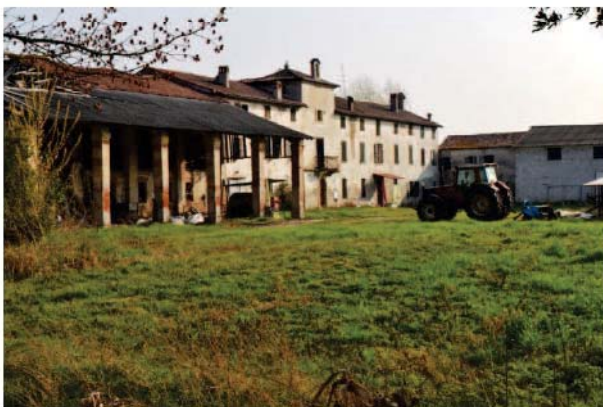
foto 4 - Scorcio del prospetto sud dell'abitazione e di parte dei rustici della corte Castelletto
