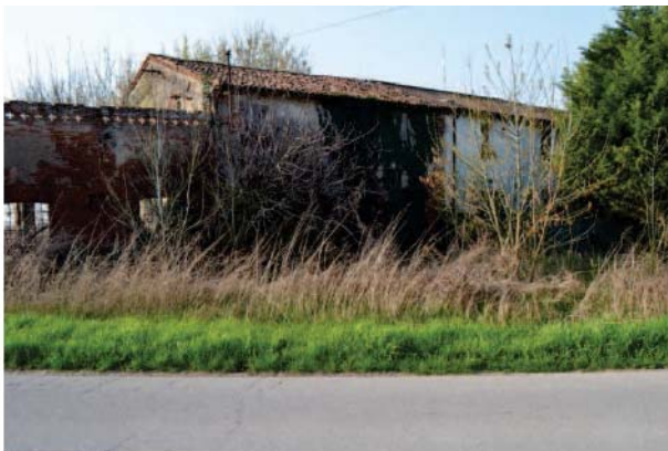
foto 12 - Prospetto nord dell’abitazione a sud di via Castelletto a Erbè (L3 - m.n. 261 sub 1)
