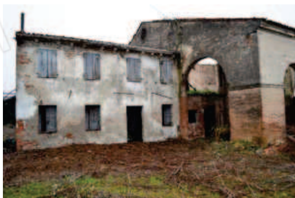
foto 8 - Scorcio del prospetto est col portico
