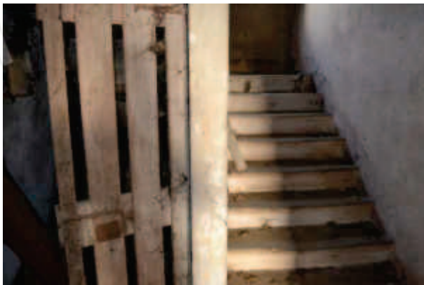
foto 13 – Scorcio della scala in pietra arenaria
