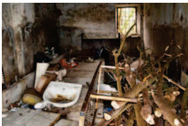
foto 26 – Vista del magazzino sotto il porticato
