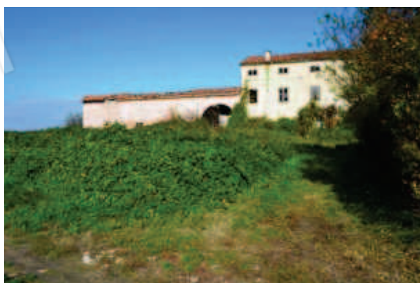
foto 3 - Scorcio prospetto sud (ingresso con arco)
