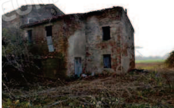
foto 10 - Scorcio del prospetto est dell'abitazione
