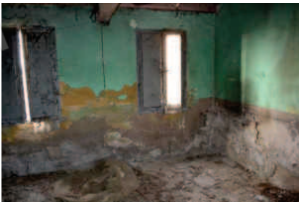
foto 22 – Vista dall'ingresso della cucina
