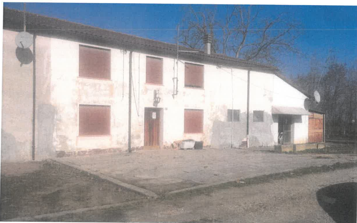
Figura 6 - La casa di Nogara in Via Oppi n. 23
