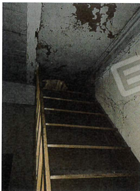
20. Scala di accesso alla soffitta: lo sbarco è atato chiuso con tavolato - p.1 (fg 8. Mapp. 323 sub 1)
