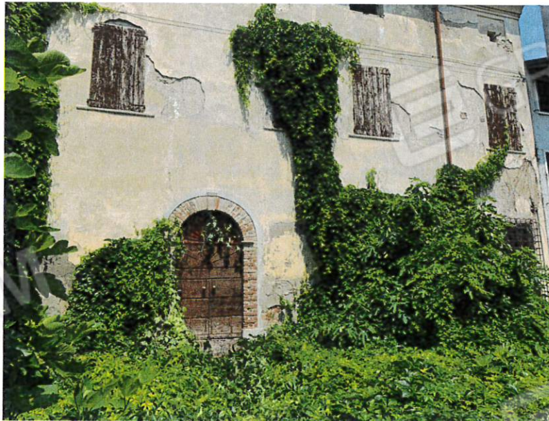
22. Ingresso alla porzione di immobile (mapp. 929)
