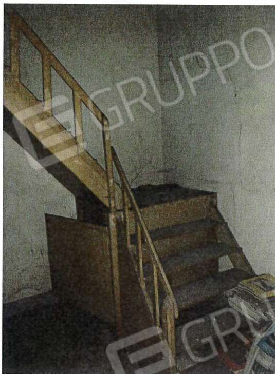
19. Scala di accesso alla soffitta - p.1 (fg 8. Mapp. 323 sub 1)
