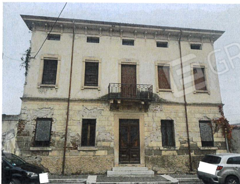
4. Facciata principale su via Vittorio Emanuele
