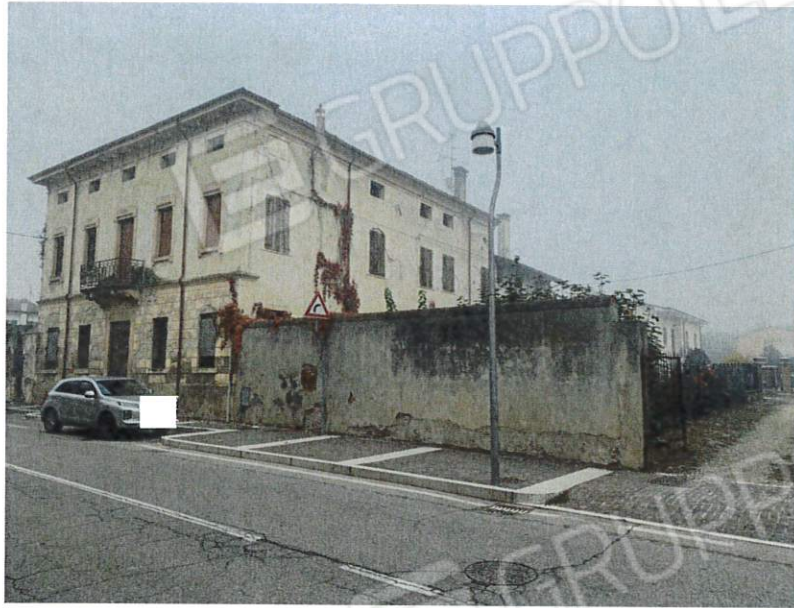
5. Facciata principale su via Vittorio Emanuele
