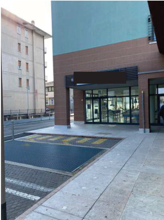
Foto 1 – Facciata esterna condominio
