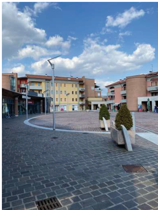
Foto 1 – Facciata esterna condominio
