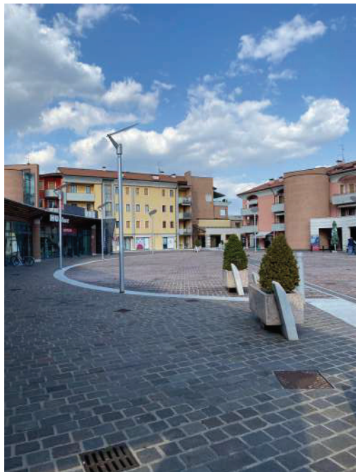
Foto 1 – Facciata esterna condominio
