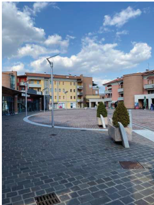
Foto 1 – Facciata esterna condominio
