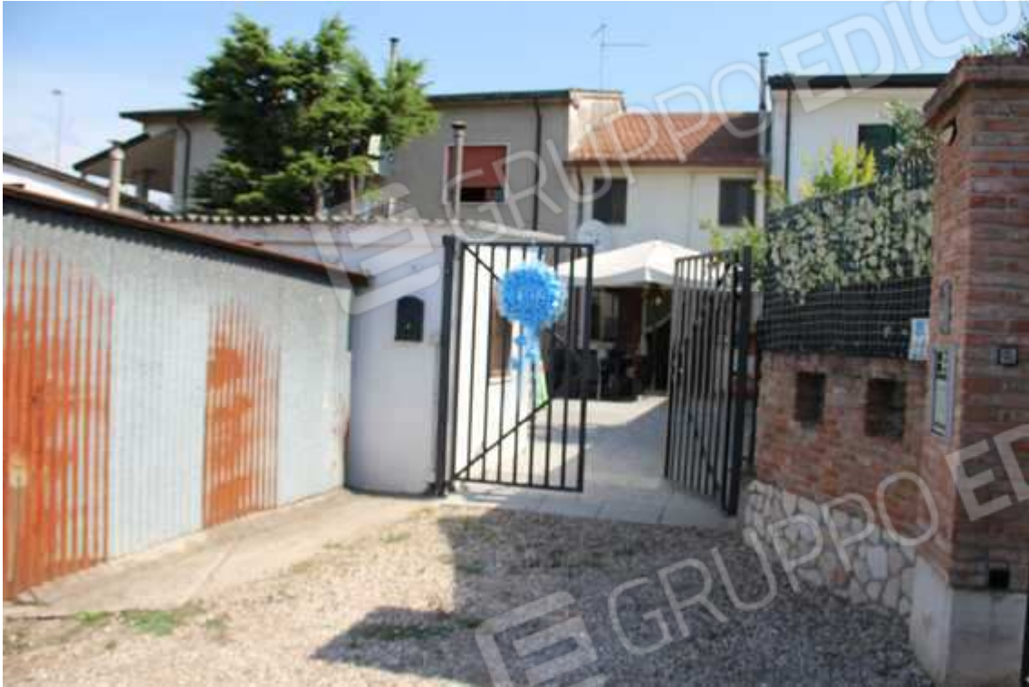
3 – CANCELLO DI INGRESSO ALLA CORTE
