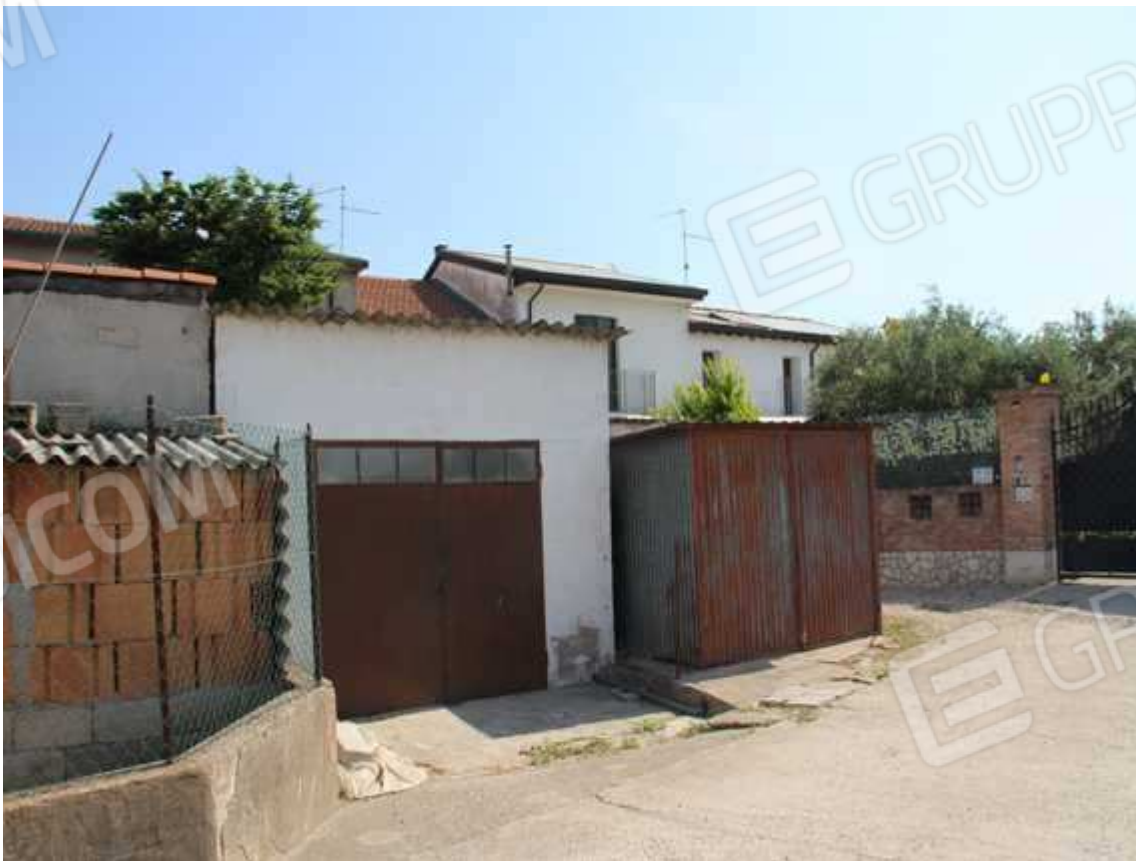
2 – STRADA PRIVATA DI ACCESSO CON AUTORIMESSA E BOX DA DEMOLIRE
