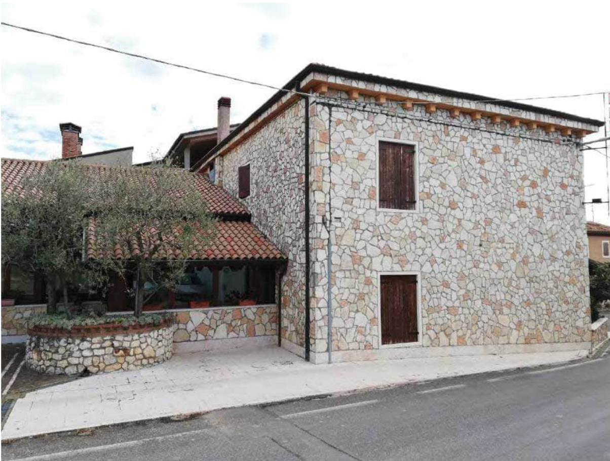
Vista Nord-Ovest dell'immobile con l'abitazione al piano primo
