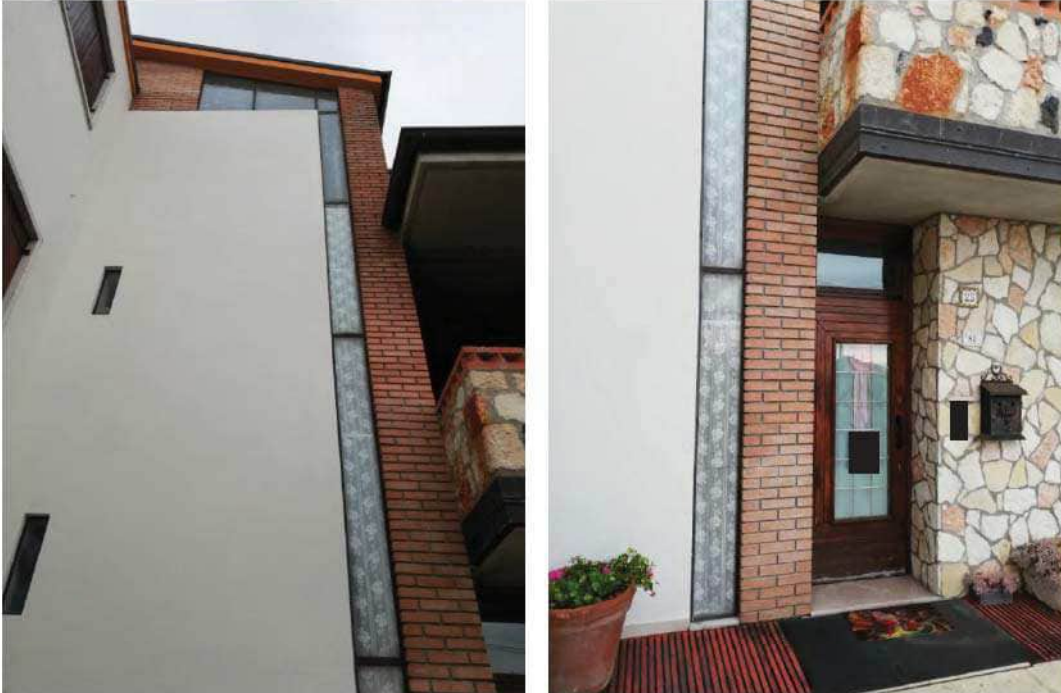
Vista del portoncino di ingresso al vano scala e del vano scala illuminato da fiestre verticali
