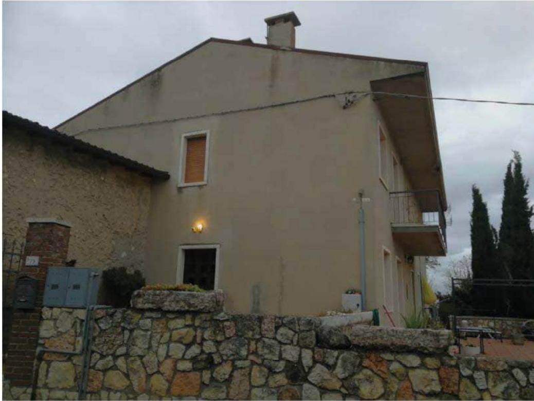
Vista frontale dell'immobile
