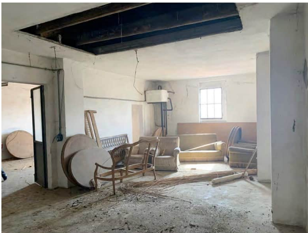
Magazzino 4 a sinistra – Porzione di terzi M. 120 sub 3 a destra
