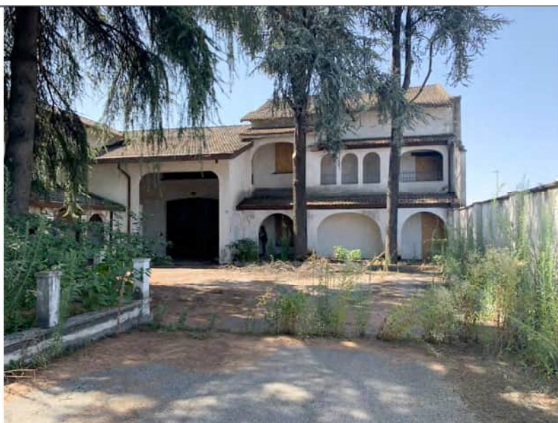
Vista d'insieme dall'area di pertinenza comune m. 103 sub 10
