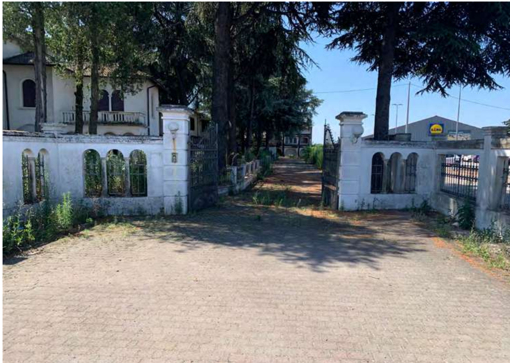
1 -Accesso pedonale e carraio attuale tramite area di terzi M. 103 sub 7 e successiva sub 8 Via Calcara n. 22 - Cerea (Vr)
