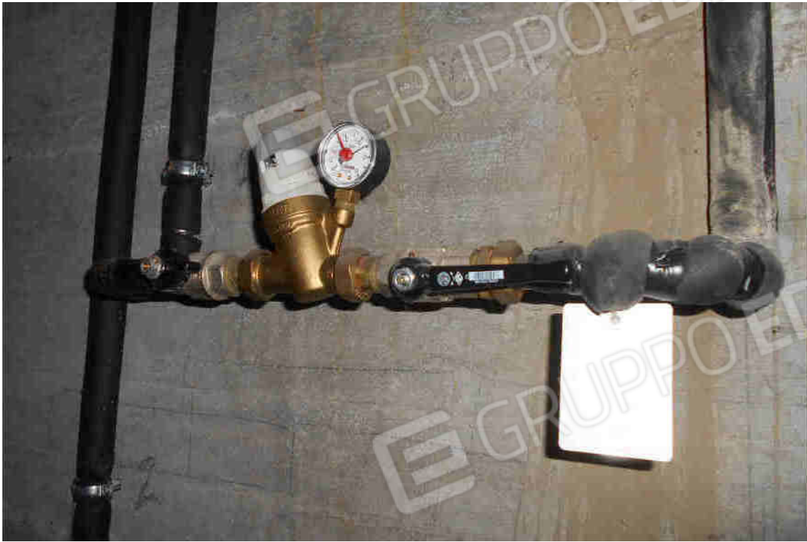
Riduttore di pressione
