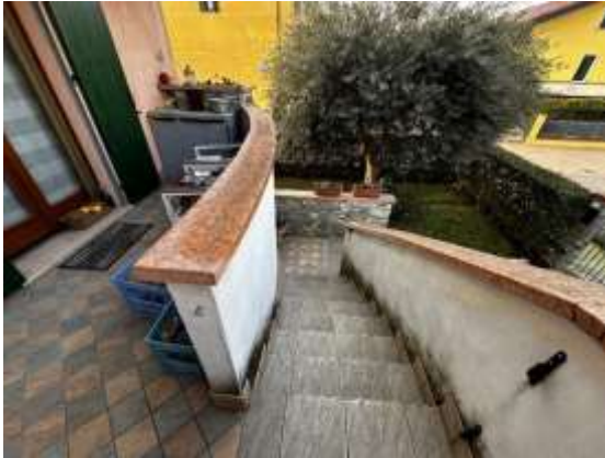
Rampa a corte lato nord
