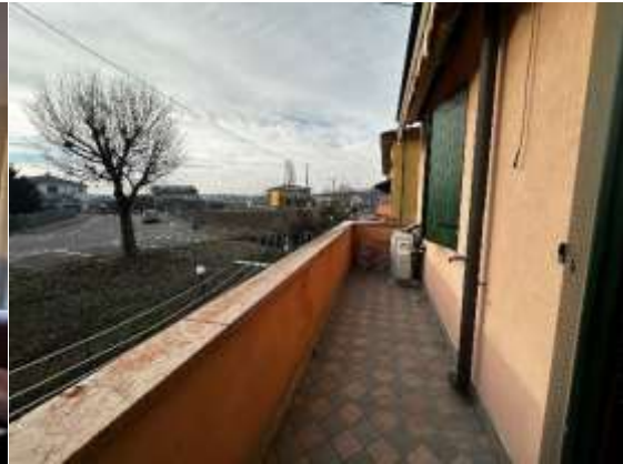
Balcone lato sud
