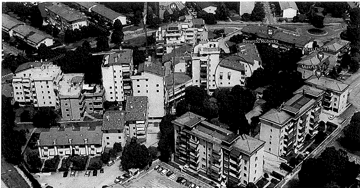
APPARTAMENTO AL PIANO 1 E DUE AUTORIMESSE° - VIA PRIMO MAGGIO 59 SCALA B INT. 3 - S. GIOVANNI LUPATOTO (VR)
