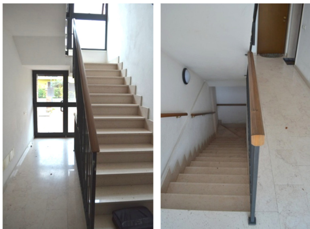
foto 4 - il vano scala comune sub 43 è finestrato piano per piano verso la strada, con aperture tali da sfruttare le piene luci architettoniche su quel lato. Le gradinate sono su solette rampanti. I rivestimenti sono in quadrotti marmorei smaltati; le finiture sono a tinte bianche
