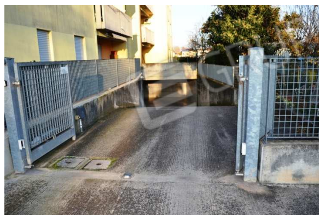
foto 21 - Rampa esterna dell'autorimessa nord est
