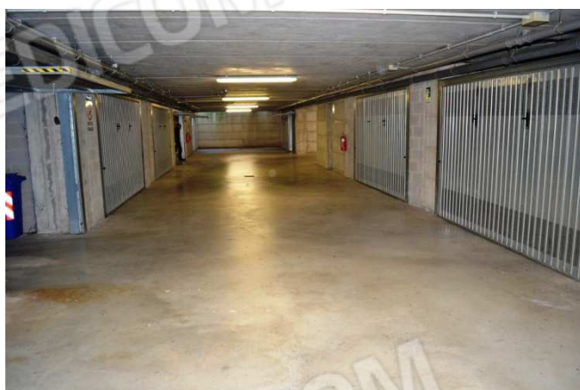
foto 20 - Vista da sud della corsia di manovra
