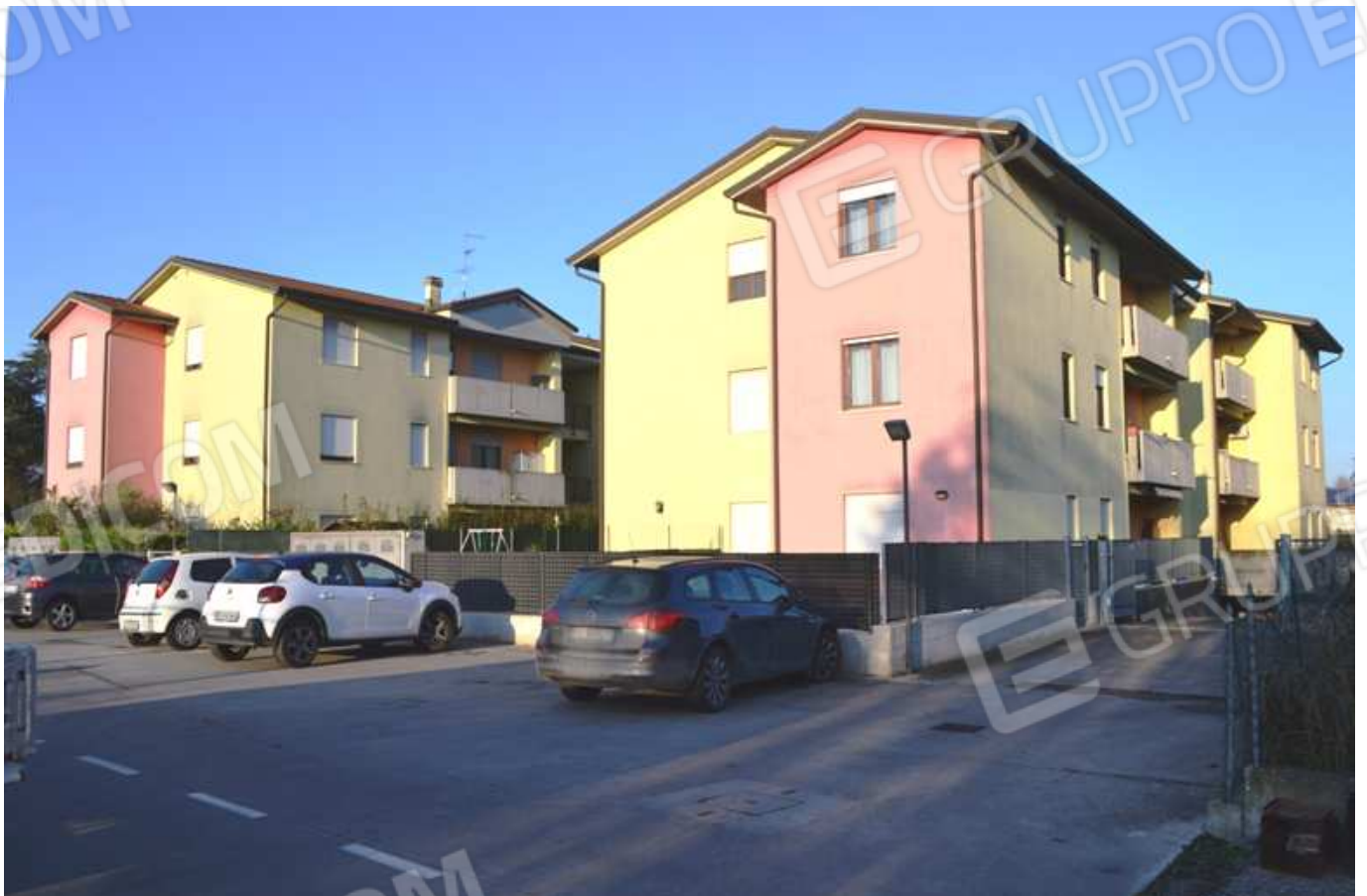
foto 3 - Prospetti sud/est del condominio LAURA in via Petrarca 53 a Cherubine di Cerea, visti da sud est
