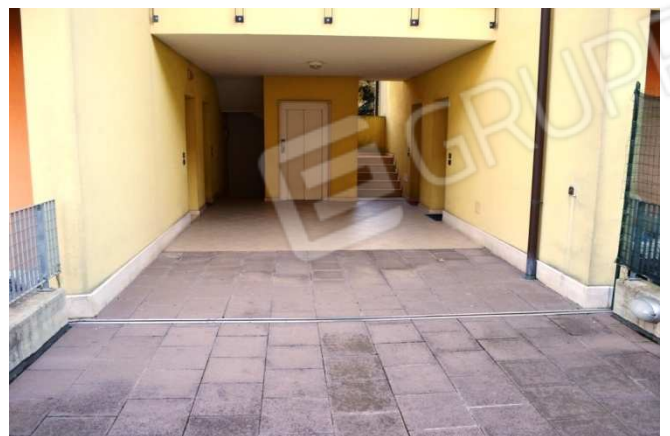
foto 8 - Vista d'ingresso e vano scala edificio nord est
