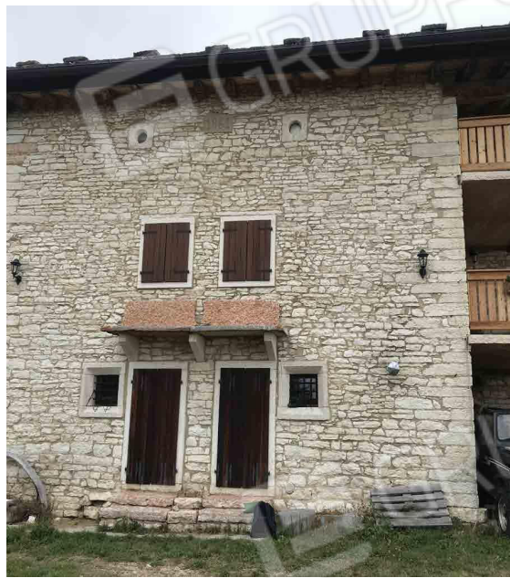
Foto 7 Prospetto Sud - Ingresso
