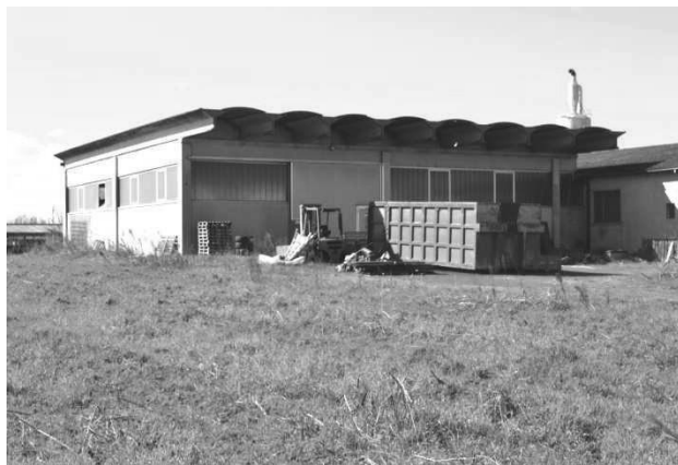
foto 1 - vista da nord est sulla via Oppioli del prospetto nord est del laboratorio m.n. 127 sub 4 col portone d'ingresso scorrevole (al centro della foto, dietro il container per il conferimento dei rifiuti di lavorazione) con copertura in copponi prefabbricati e precompressi e finestre perimetrali
