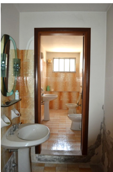
foto 16 - sub 4 (anti) - Primo la-vabo; efflorescenze muffite.
