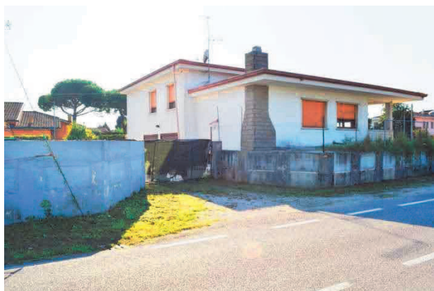
foto 2 - scorcio del prospetto nord est della villa sul m.n. 1402 CT con l'ingresso carraio con stallo d'invito esterno alla recinzione accessibile direttamente dal lato sud ovest della via Strà: la spalla del muro alla sinistra della foto delimita il m.n. 1402
