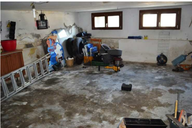
foto 25 - Scorcio della cantina a piano seminterrato
