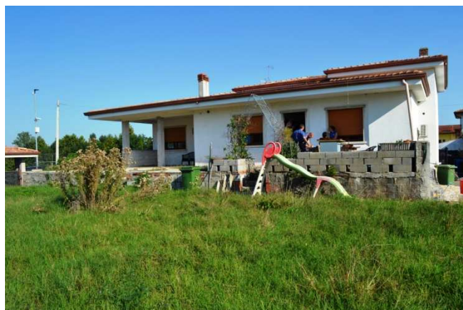
foto 6 - Prospetto nord ovest con ingresso a p. rialzato
