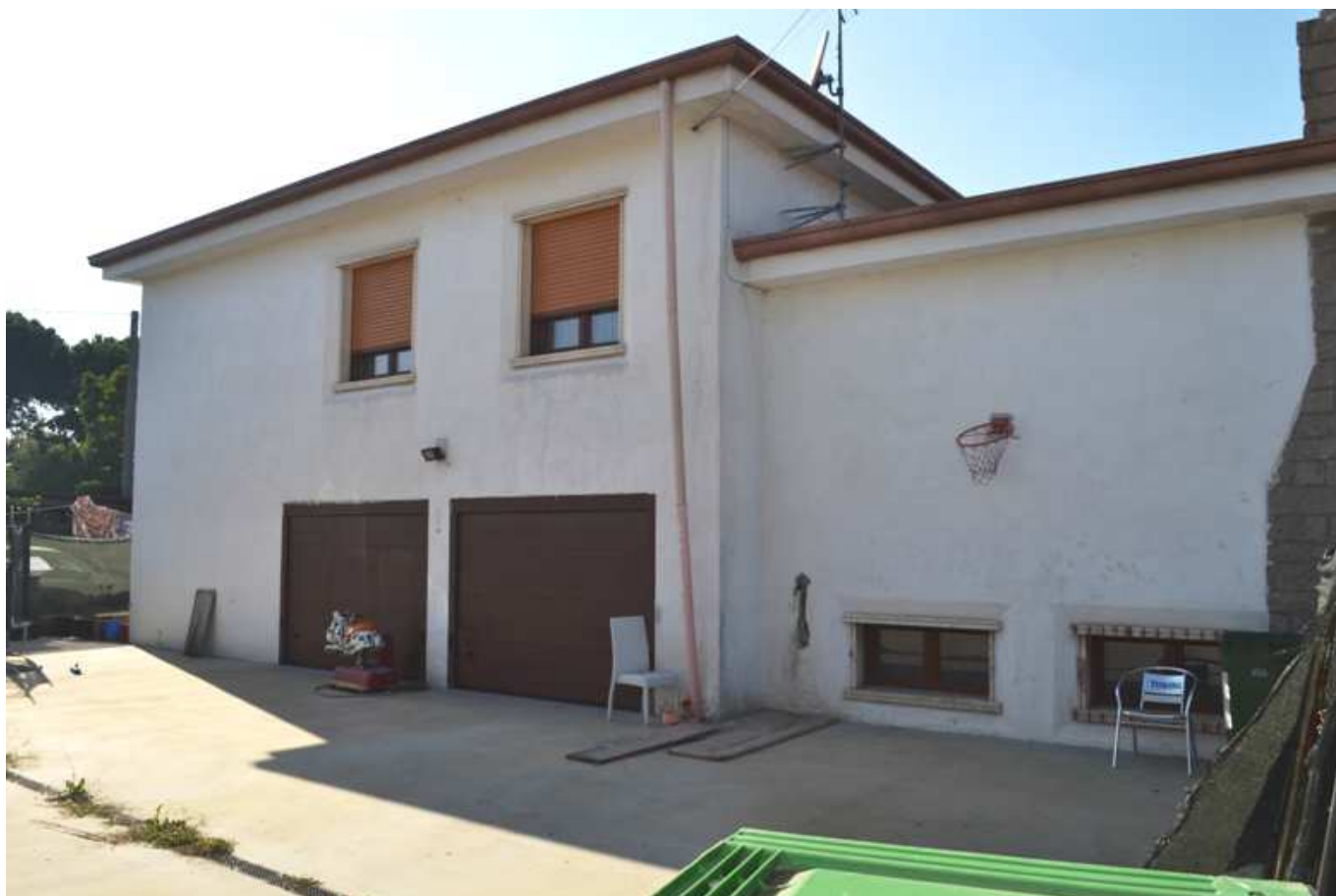
foto 4 - Scorcio del prospetto sud est dell'abitazione in via Strà n. 71 con gli accessi all'autorimessa
