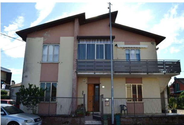
foto 1 - lungo il perimetro della proprietà bifamiliare, sopra i muretti di confine, sono fissate recinzioni in comune ferro battuto. In copertura, gli sporti di gronda raggiungono circa il metro di aggetto, evidenziando la rientranza della cornice perimetrale in corrispondenza della concavità di sedime, con due giaciture di falda utili. Evidenti i segni di degrado sulle finiture esterne
